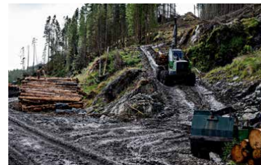
BYNÆRT SKOGBRUK: Gjorme og brattlendt terreng stanser ikke skogsmaskinene som henter ut tømmer fra liene under Vetten i Åsane.
