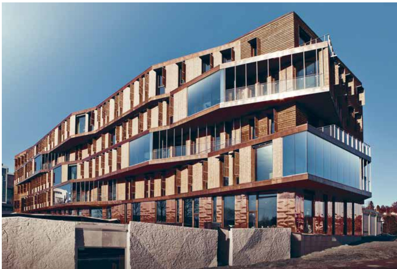
NINA-bygget på Gløshaugen er bygget med massive tredekker og trekledning. Foto: Sindre Karlsen
