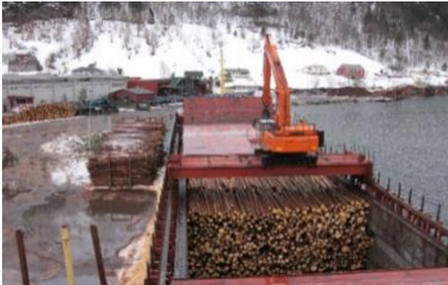
Moelven Granvin Bruk. Det er lasteskipet Heidi fra Myklebusthaug Rederi (fra Storesletten Rederi da bildet ble tatt) som ligger ved kai i Granvin. Den nye tømmerkaien skal bygges i forlengelsen av denne.
