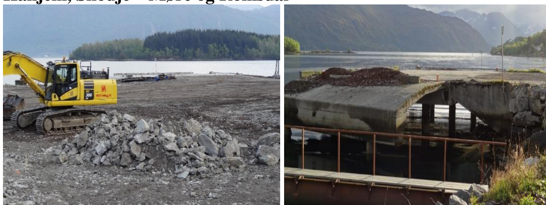
Bilde t.v. Håhjem i Skodje under anleggsarbeidet i 2015.
