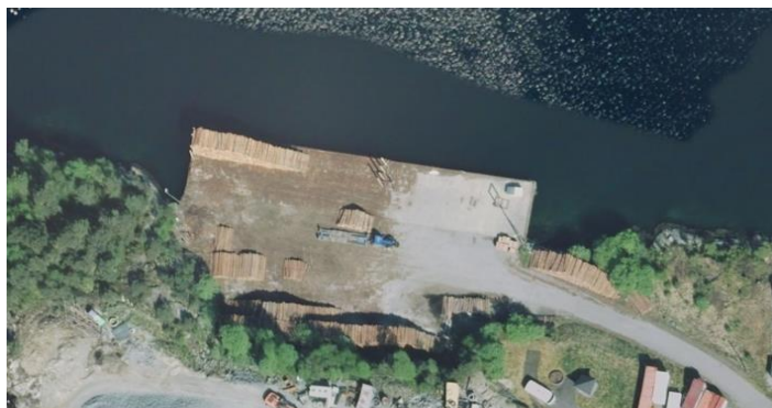
Børnes tømmerkai. Søre Kvinnherad sin tømmerkai til venstre (40 m) og Kvinnherad kommune sin kai til høyre (33 m)
