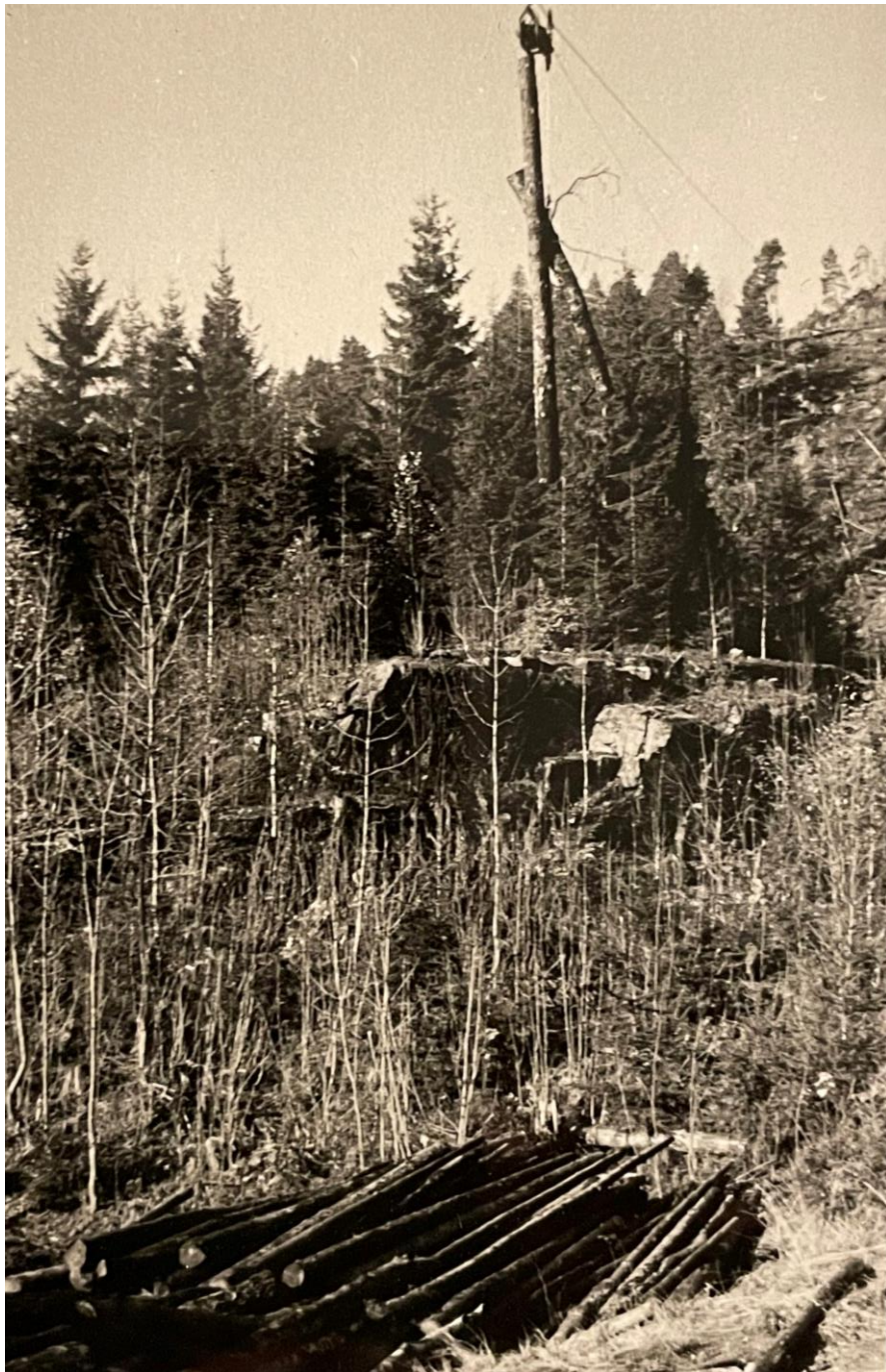
Kabelkranen «Heiavinsjen» i drift hos Treschow-Fritzøe i 1966.
